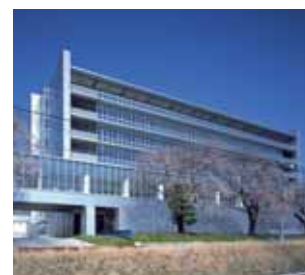
▲八王子技術センターの建物外観
