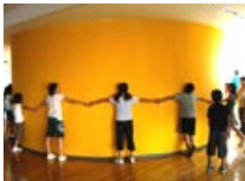
八王子技術センターの見学（高効率型蓄熱槽）
