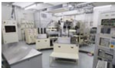
ドライエッチング設備。左端に見えるのが F 2 ガスを管理し、中央部へガスを供給する設備。
